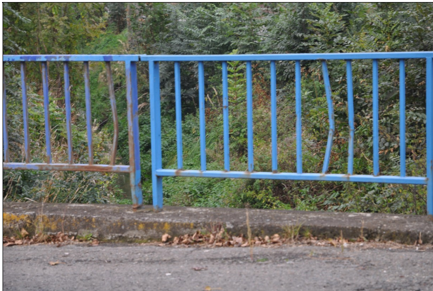
Deformace zábradlí vpravo.
