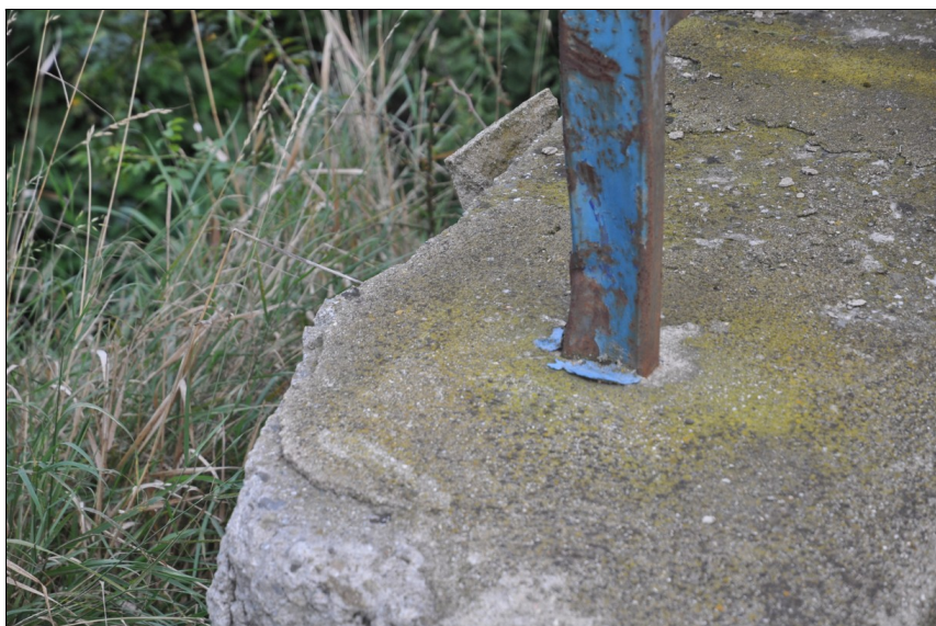
Poškozená římsa a sloupek zábradlí vlevo.
